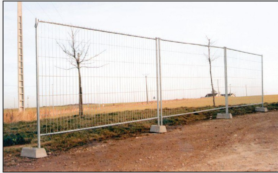
Exemple de palissade de protection de chantier (source : www.signals.fr)
